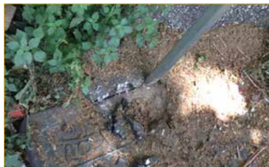
Utile per tagliare strati di asfalto e cemento, pulire e scrostare lo sporco, che spesso ricoprono la superficie e la giuntura del coperchio e permetterne l'apertura.
