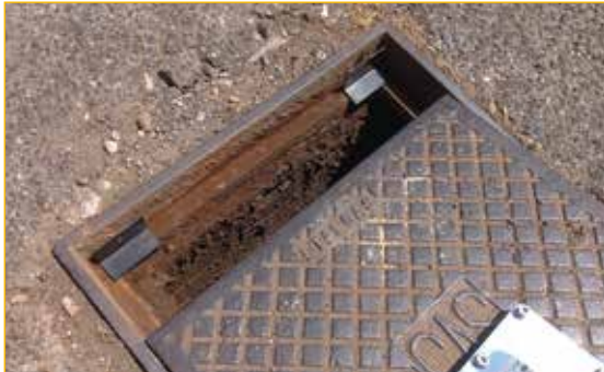
Posizionamento degli spessori tra coperchio e cornice.
