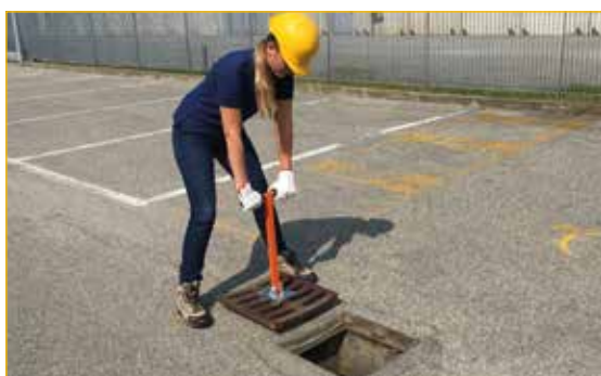
Sollevamento manuale di coperchi metallici medio/leggeri.
